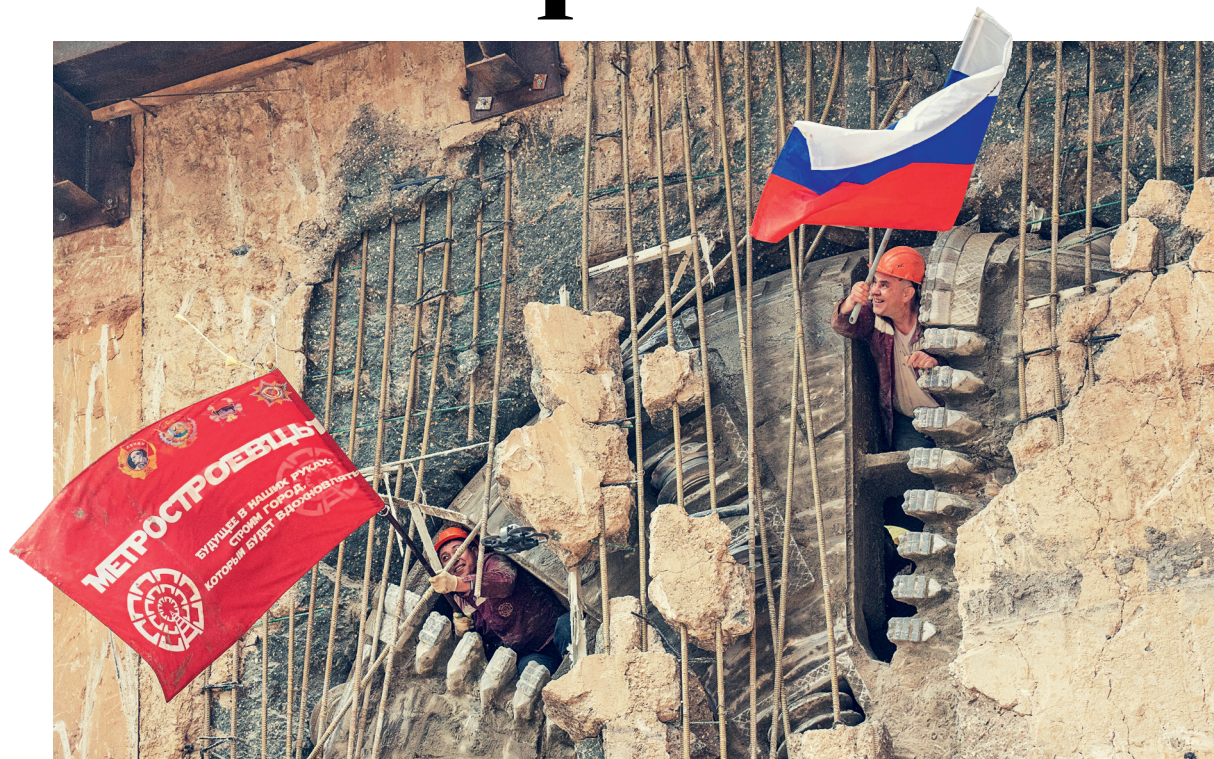
Проходческий щит «Галина» финишировал
