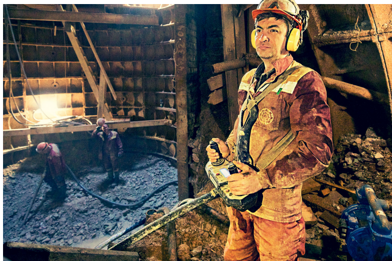
На сооружении станции «Достоевская»-кольцевая
