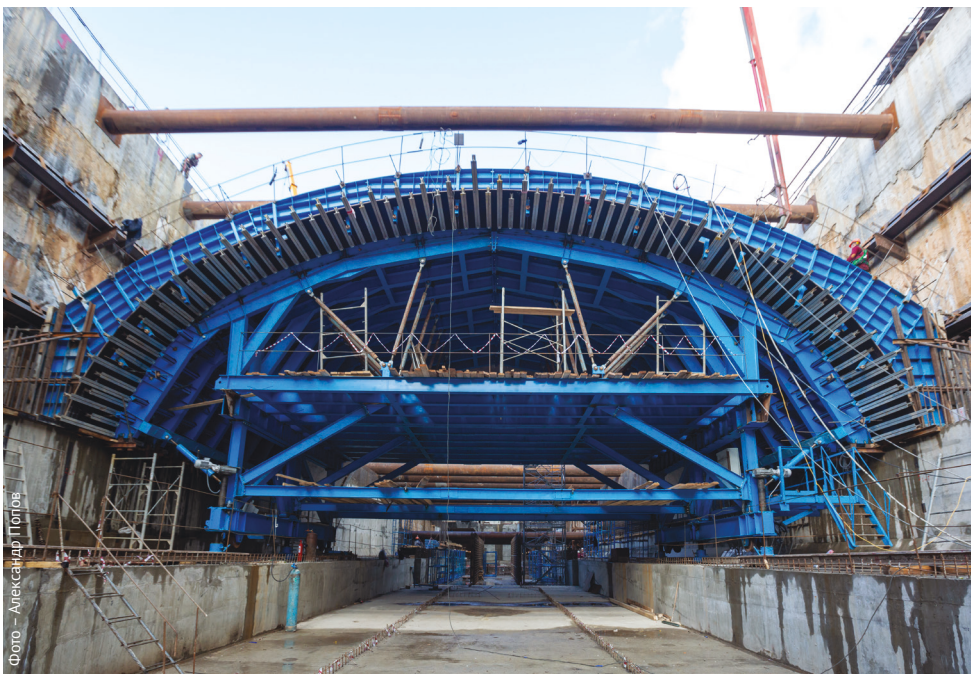
Передвижная механизированная опалубка на станции «Физтех»
