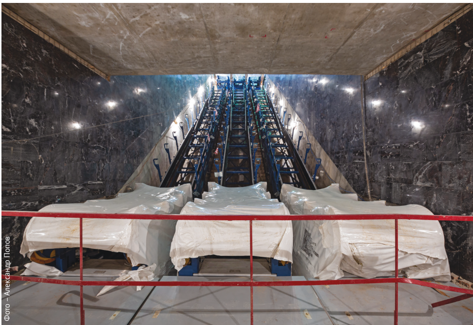
Смонтированные фермы эскалаторов южного вестибюля «Лианозово»
