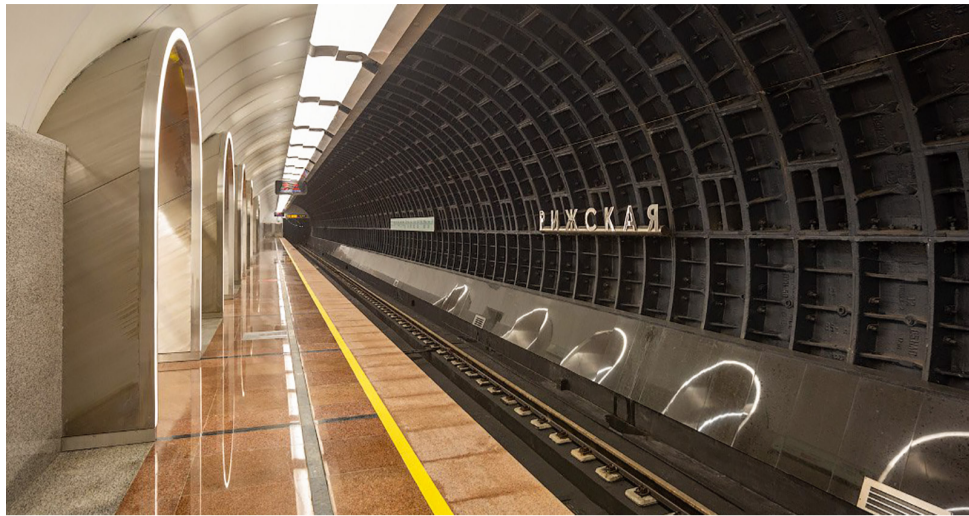
Чугунные тоннельные тубинги в оформлении «Рижской»
