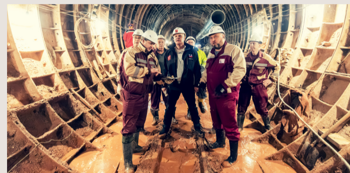
В обходном тоннеле будущей станции «Достоевская»
