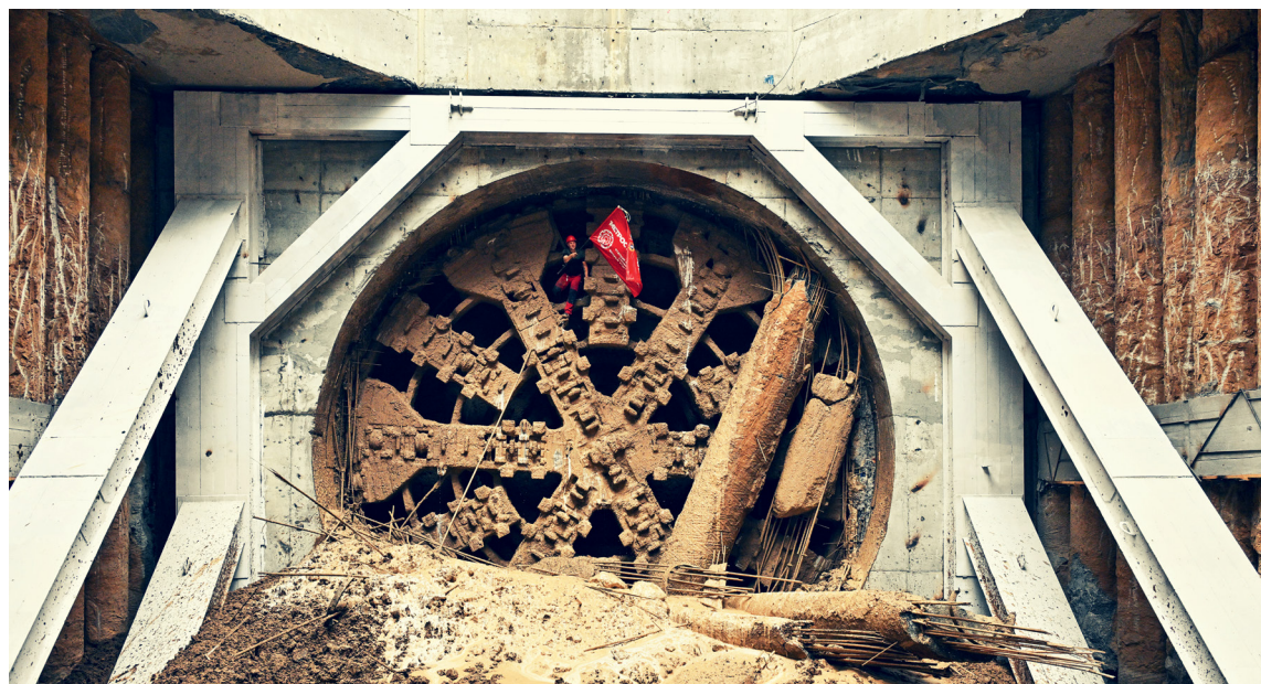
Проходческий комплекс 10-метрового диаметра завершил строительство двухпутного тоннеля на участке «Липовая роща» — «Строгино»
