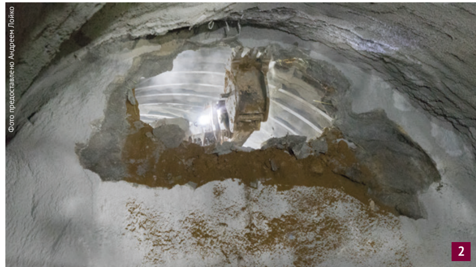
3 апреля 2020 года. Состоялась сбойка правого тоннеля «Чортановцы» (1) Строители шли навстречу друг другу с южного и северного порталов (2) Последние сантиметры грунта перед соединением тоннелей (3)
