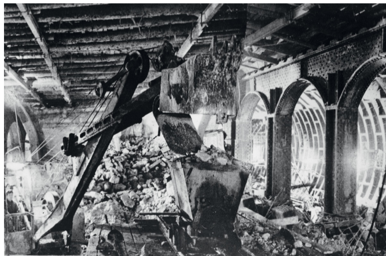
Строительство станции «Маяковская»
