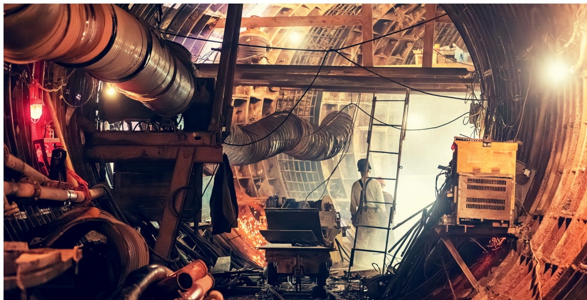
Работы по сооружению станции метро «Достоевская»-кольцевая — одни из самых сложных на строительстве столичной подземки
