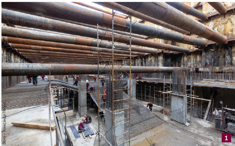
Станционный зал «Сокольников» БКЛ. Идет сооружение лестничной галереи, балконов и колонн (1) Подготовка арматурного каркаса на колонне станции (2)
