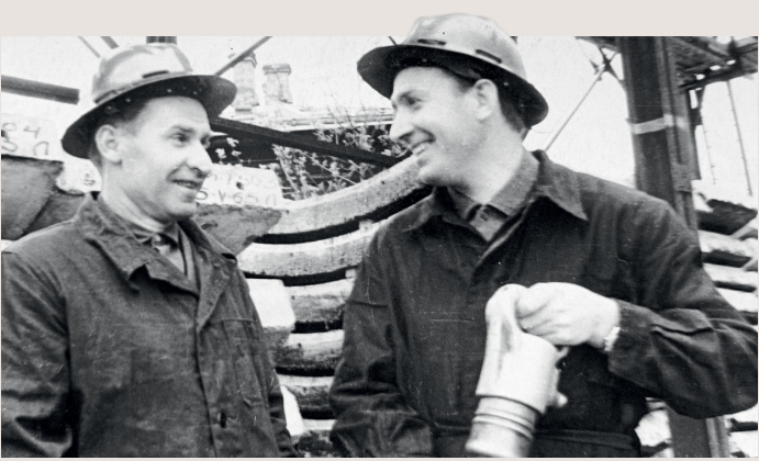
Заслуженные строители РСФСР, бригадиры проходчиков И. Костенко и С. Моисеенков
