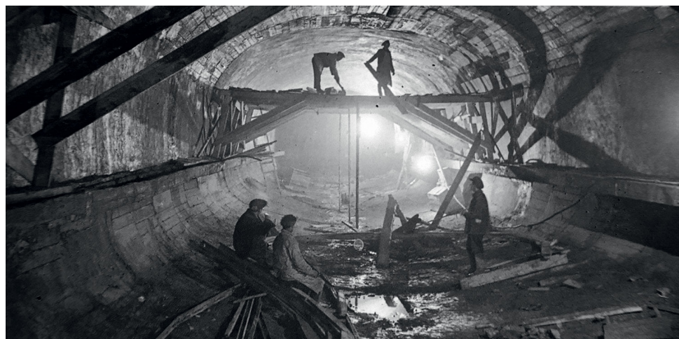
В одном из первых тоннелей московского метро. Приблизительно 1934 г.
