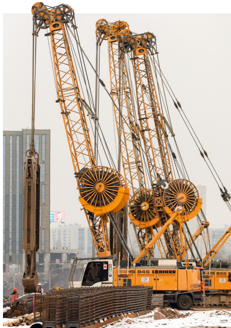
Стройплощадка расположена на территории Московской области вдоль МКАД
