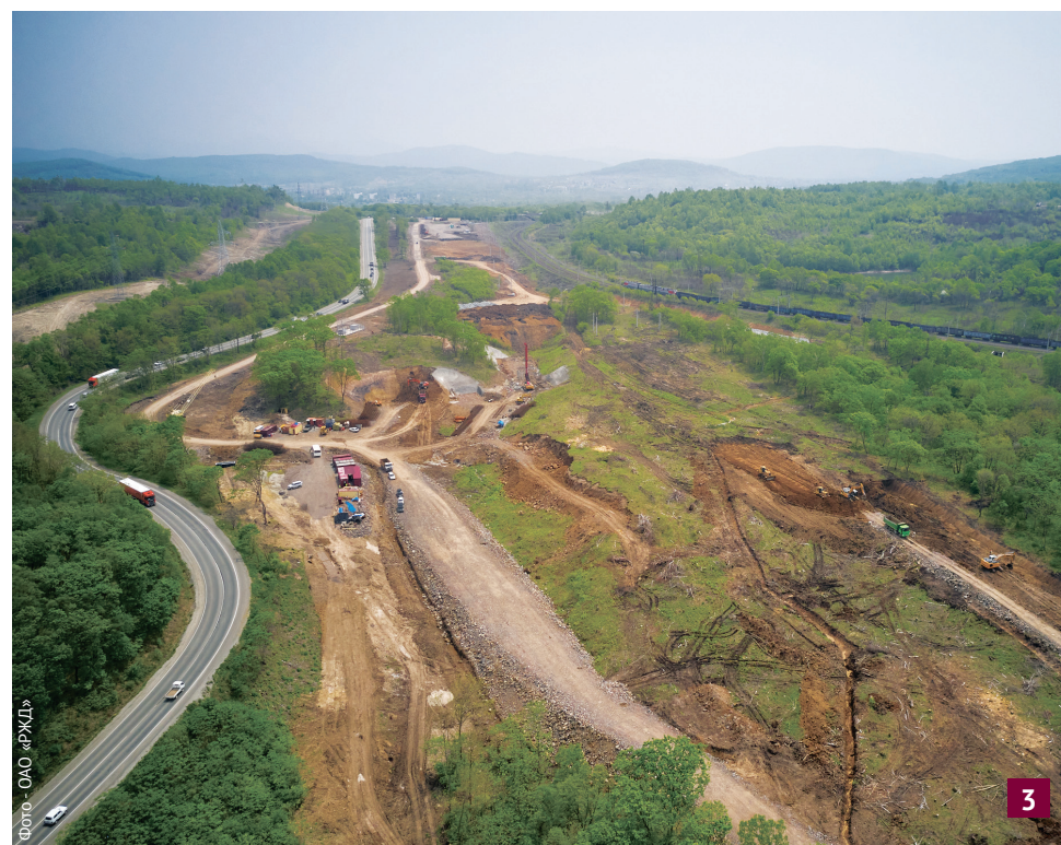
Метростроевцы отметили первые 100 погонных метров калотты – верхнего уступа тоннеля второго пути (1)
