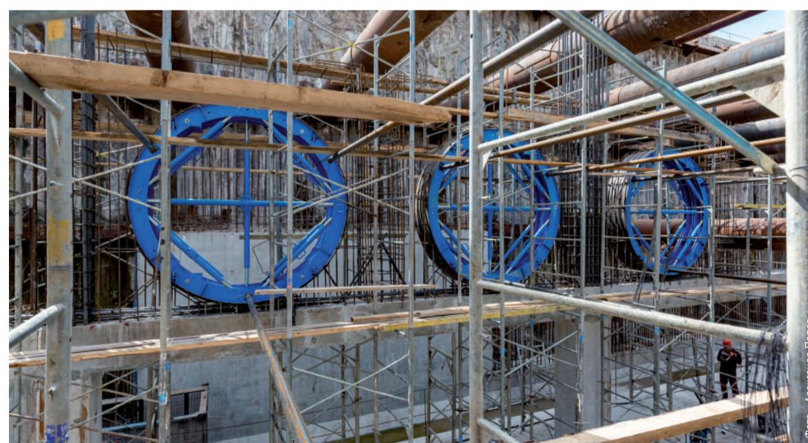
Синяя металлическая опалубка – задел для будущего освещения станции
